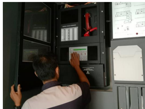
ช่างตรวจสอบอุปกรณ์ป้องกัน และแจ้งเหตุเพลิงไหม้
