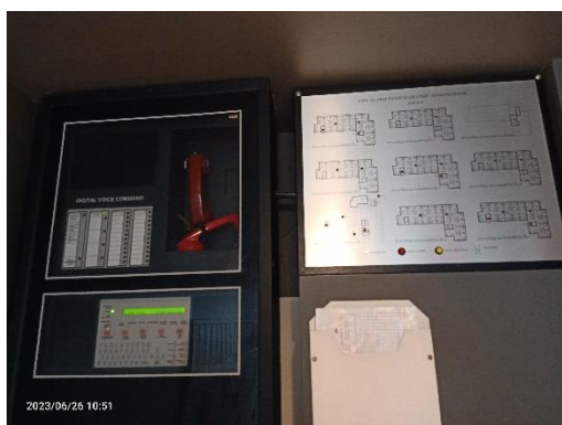
แผงควบคุมระบบแจ้งเหตุอัคคีภัย (Fire Alarm Control Panel ; FCP) อาคาร D และ อาคาร E
