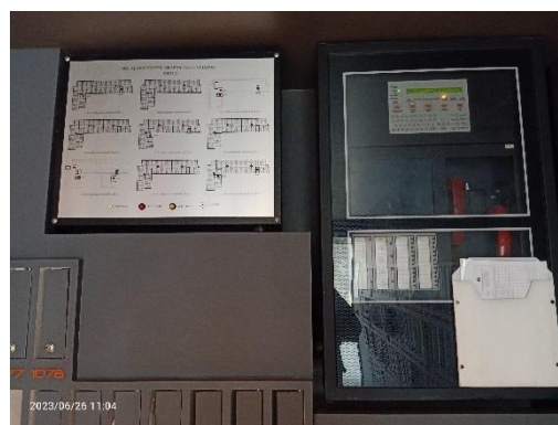
แผงควบคุมระบบแจ้งเหตุอัคคีภัย (Fire Alarm Control Panel ; FCP) อาคาร D และ อาคาร E
